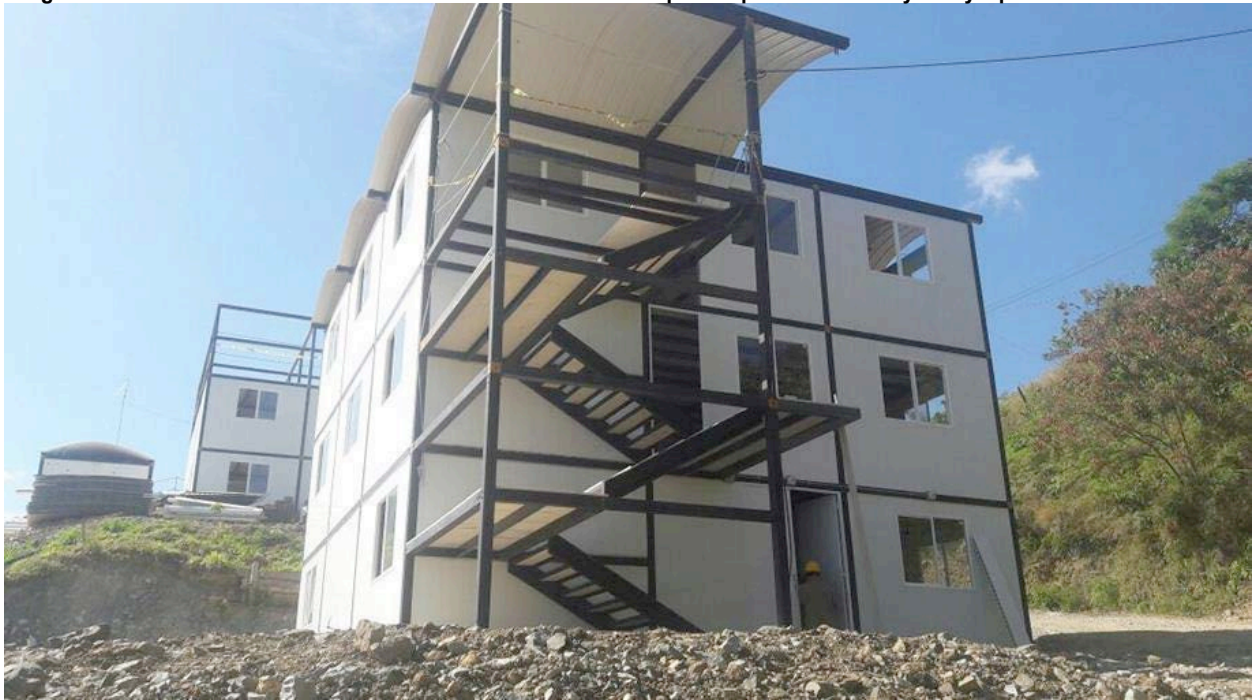
Imagen 4: Instalaciones modulares de oficinas siendo instaladas para el personal de Proyecto y Operaciones.
